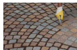
Le scellement du revêtement de sol par coulée de résine est une technique qui réduit considérablement le temps de prise. De plus, la résine rend les joints plus résistants et élastiques, réduisant ainsi les risques de détérioration et de dégradation dans le temps.
