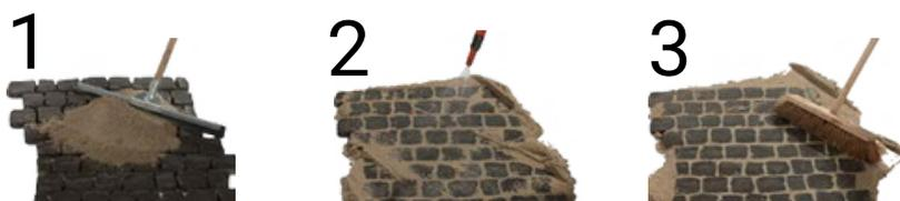
1. Le mélange de résine et de sable est étalé sur la surface préparée et préalablement bien humidifiée à l'aide d'une raclette en caoutchouc.
